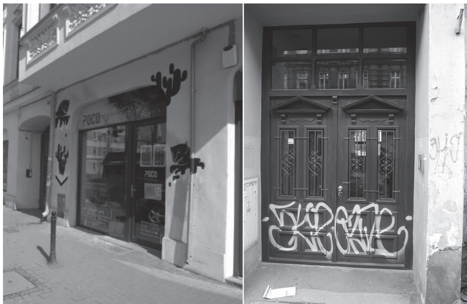
Fot. 2. Elementy konfliktu o przestrzeń – oblane farbą witryna sklepowa oraz drzwi wejściowe do kamienicy Źródło: Jak w fot. 1.
